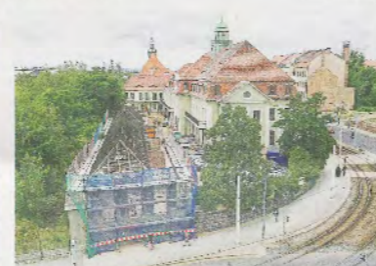
Foto von der Sanierung. Ins Gebäude vorn links zog mittlerweile die Advita-Verwaltung ein. Foto: Nikola Schmidt
