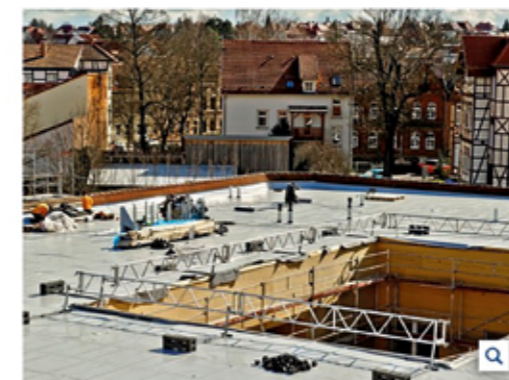
Um mehr Tageslicht in die Wohnungen gelangen zu lassen, wurde die Decke der ehemaligen Möbelhalle geöffnet. Foto: Daniel Volkmann
