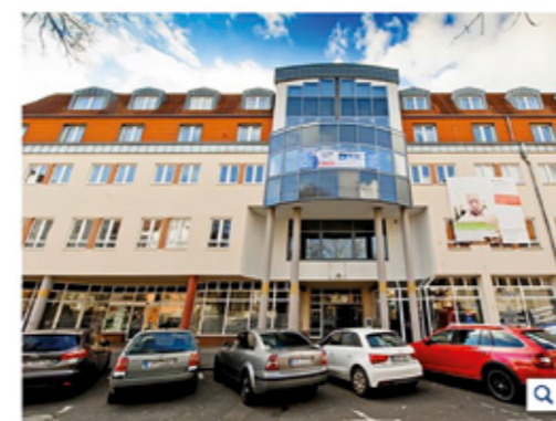
Das ehemalige Mühlhäuser Mirage-Hotel in der Karl-Marx-Straße wird zu einem Seniorenwohnpark umgebaut. Foto: Daniel Volkmann
