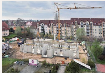
Die Arbeiten am neuen Gebäude an der Güterbahnstraße in Radeberg sind in vollem Gange. Vier Stockwerke sind es künftig haben.
