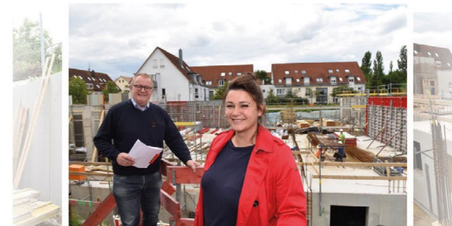
Advita-Pflegedienstleiterin Susann Flade und Bauüberwacher Peter Füll informieren sich über den Baufortschritt auf der Baustelle. © Egbert Kamprath
