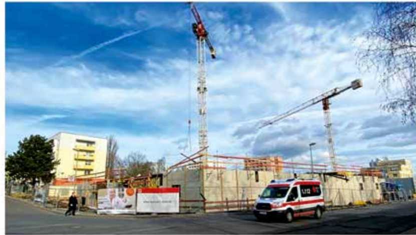
Der Konsum-Neubau Panoramablick wächst sichtbar. Kommende Woche wird die erste Anlieferung von Deckenteilen für das Erdgeschoss erwartet. Foto: Michael Baar
